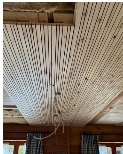
Einbau der Akustikdecke Foto: T. Jauernig
