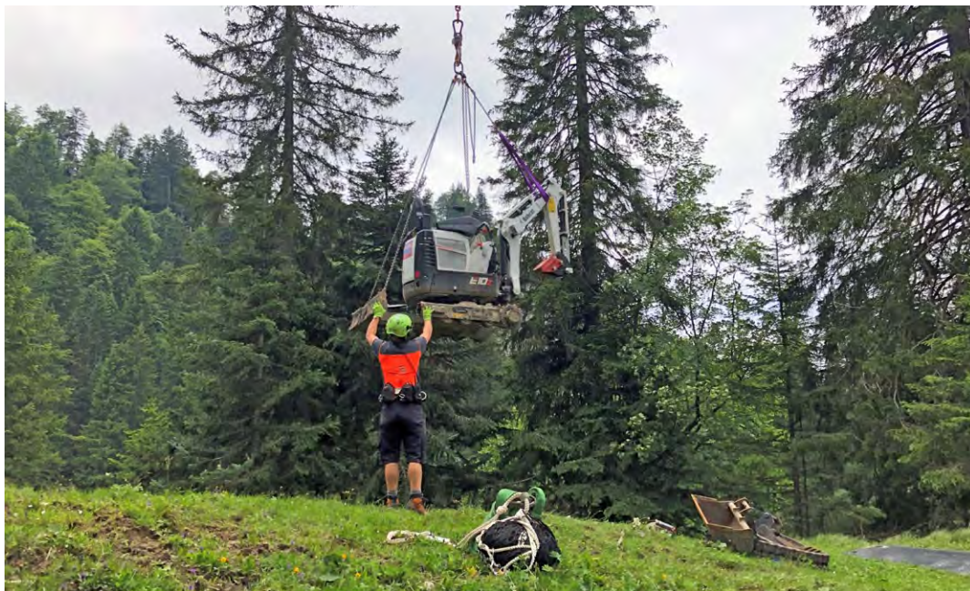
Der Minibagger schwebt am Hub- schrauberseil ein. Foto: Stephan Glaser
